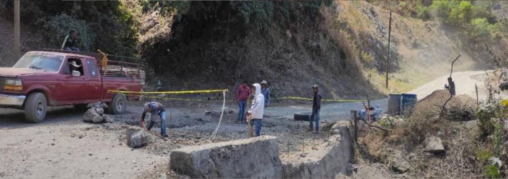
Rehabilitación de camino sacacosecha en la localidad de Hueycantenago-Ixcátla.
