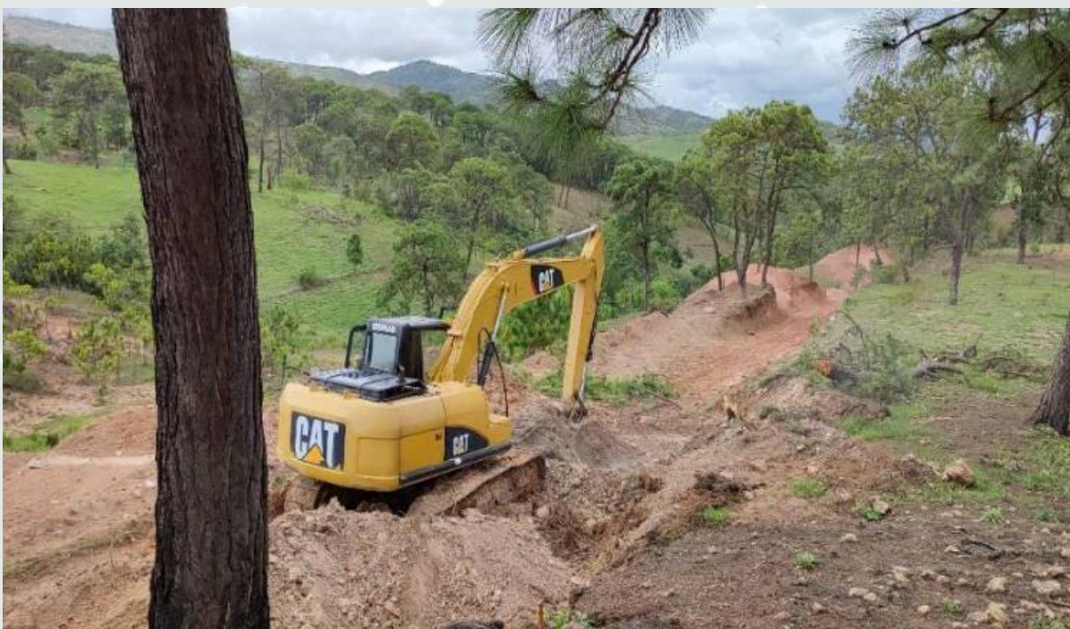
Apertura de brecha de la localidad San Marcos Ixtlahuac -Ahuixtla.
