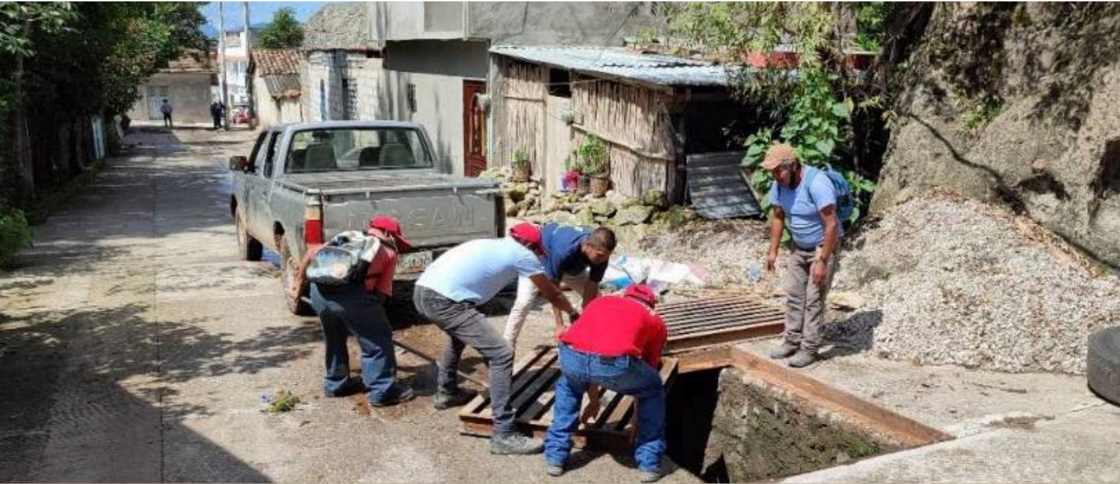
Desazolve de alcantarillado en la localidad de Hueycantenango.
