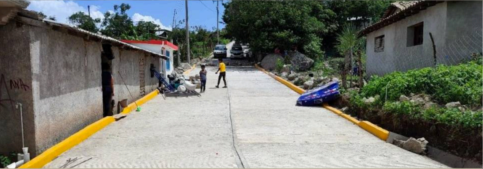
Construcción de pavimentación con concreto hidráulico en la calle principal de la localidad La Laguna.
