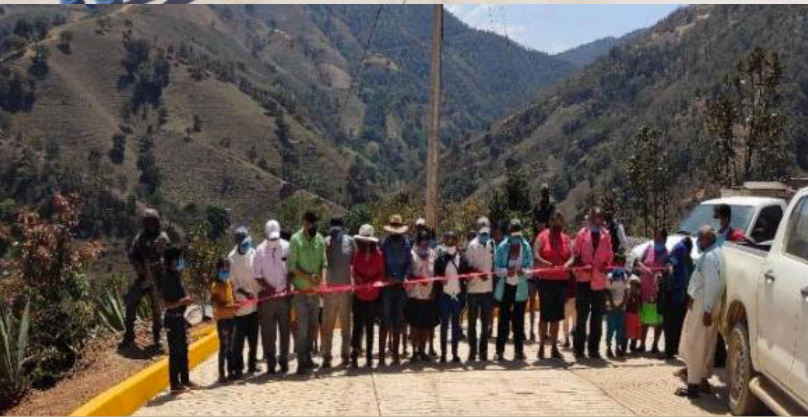
Construcción de pavimentación con concreto hidráulico en la calle principal, localidad Dos Paños.
