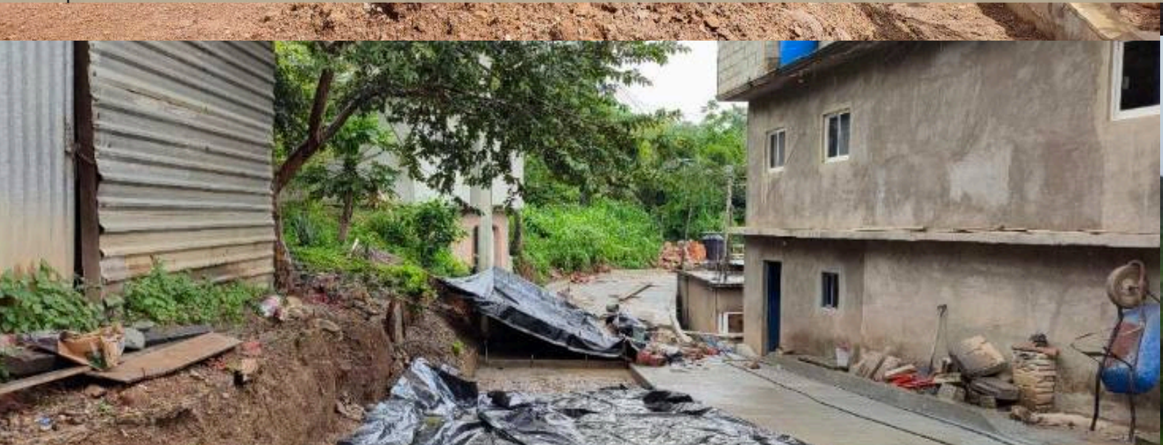
Construcción de pavimentación con concreto hidráulico de la calle principal en localidad Ixcatla.
