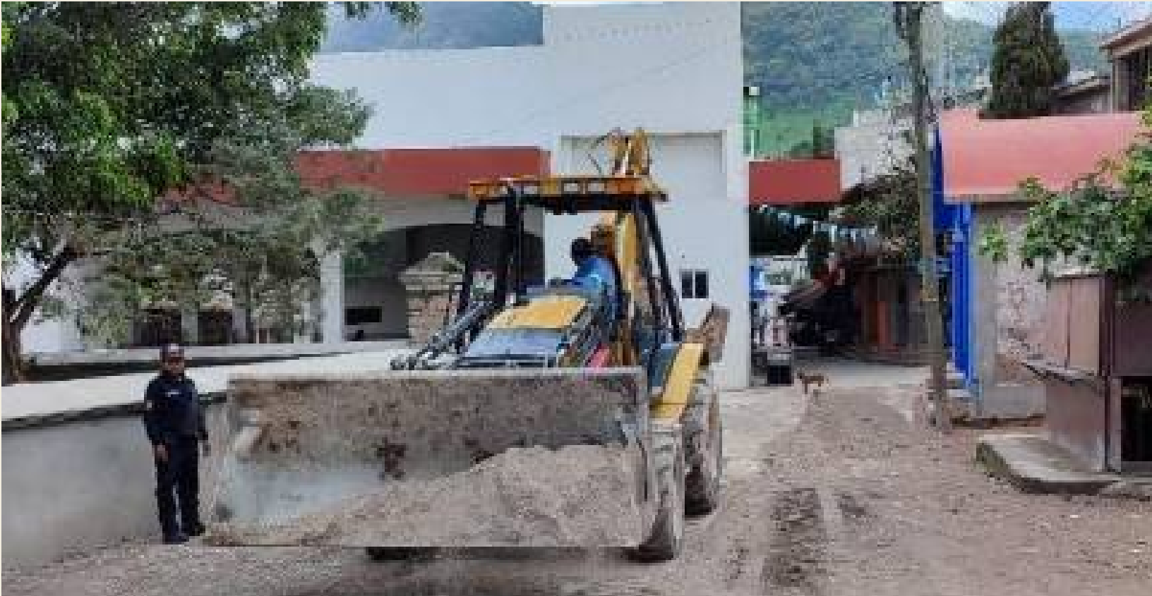
Rehabilitación de calle Miguel Hidalgo revestimiento.
