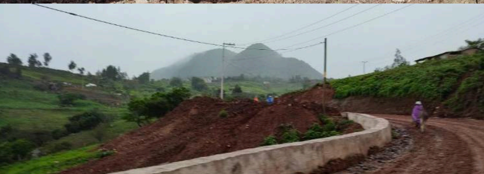
Construcción de pavimentación del camino rural Hueycantenango-Ixcátla.
