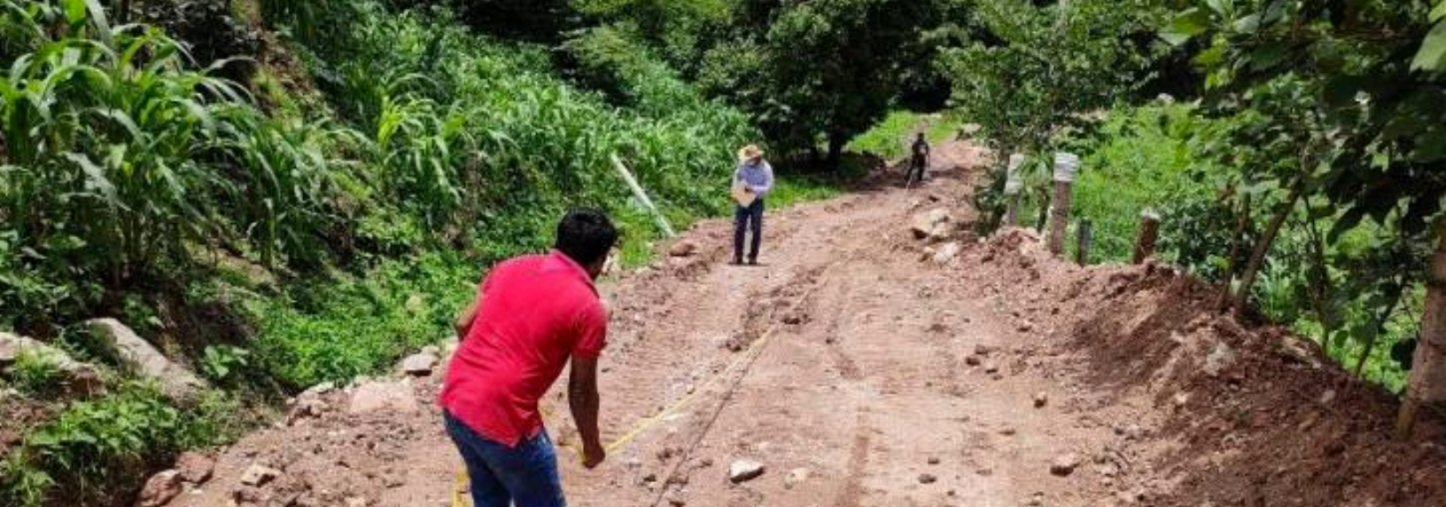
Construcción de drenaje sanitario en la localidad Tequixca.
