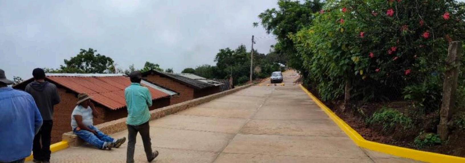
Construcción de pavimentación con concreto hidráulico de la calle principal en Tomactilicán.
