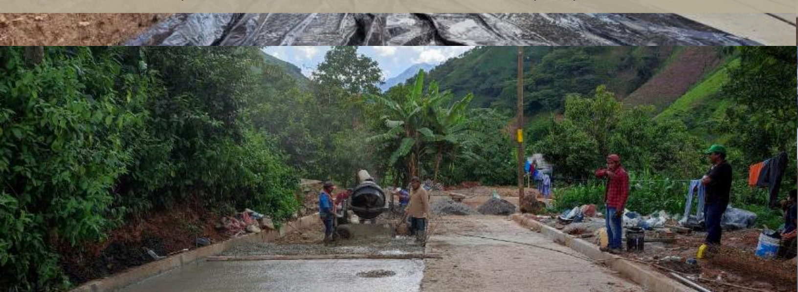
Construcción de pavimentación con concreto hidráulico de la calle principal en la localidad Tlachichiltipan Nuevo.
