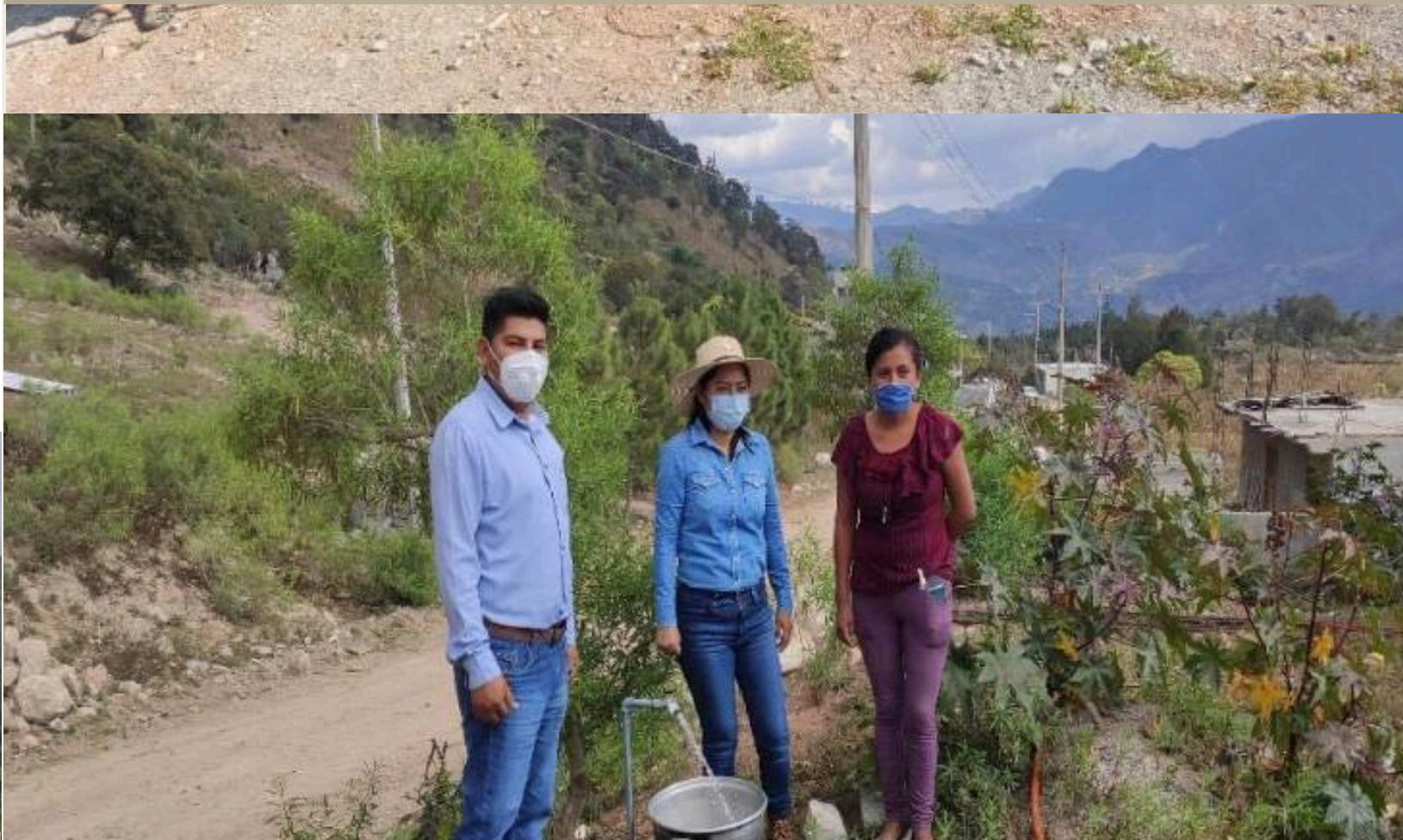
Sistema de agua potable del municipio José Joaquín de Herrera, Gro., localidad de Hueycantenango.
