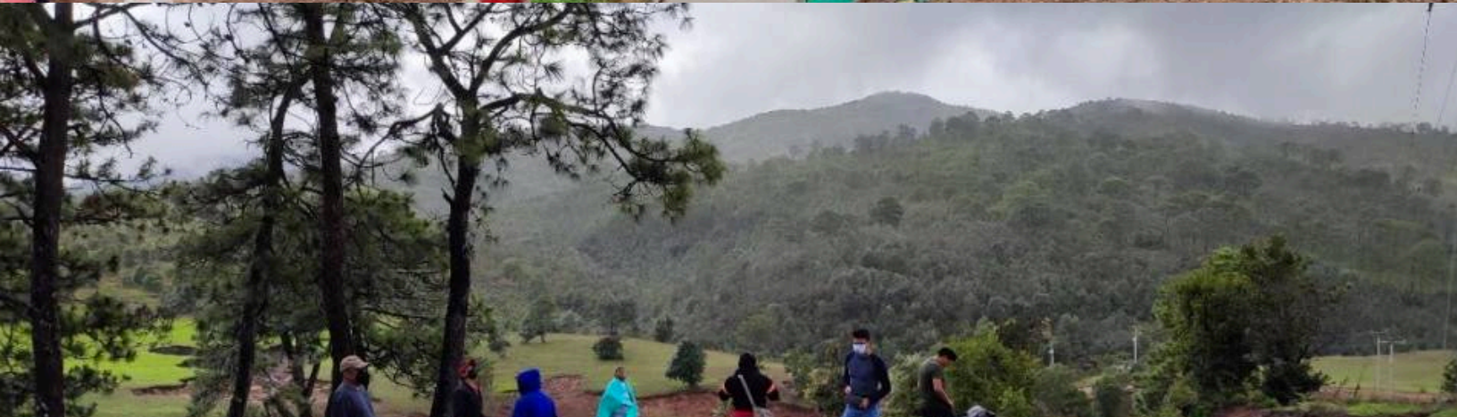
Construcción del sistema de agua potable (galería filtrante vertical, cárcamo y equipo de bombeo), tanque de regulación de 300m 3 , 1.07 km de línea de conducción de Fo.Go. De 4" de diámetro, red de distribución con tubería de pvc y Fo.Go. Con una longitud de 4 km.
