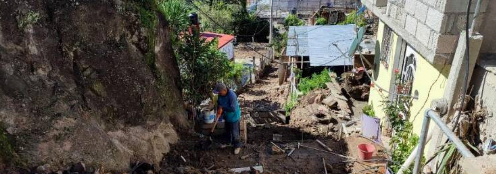
Construcción de pavimentación con concreto hidráulico de la calle Benito Juárez en Hueycantenango.
