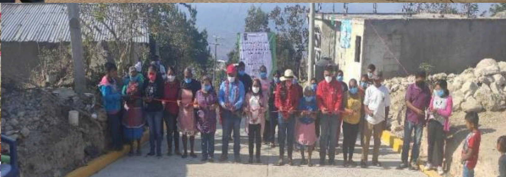
Construcción de pavimentación con concreto hidráulico en la calle Los Angeles, localidad Hueycantenango.
