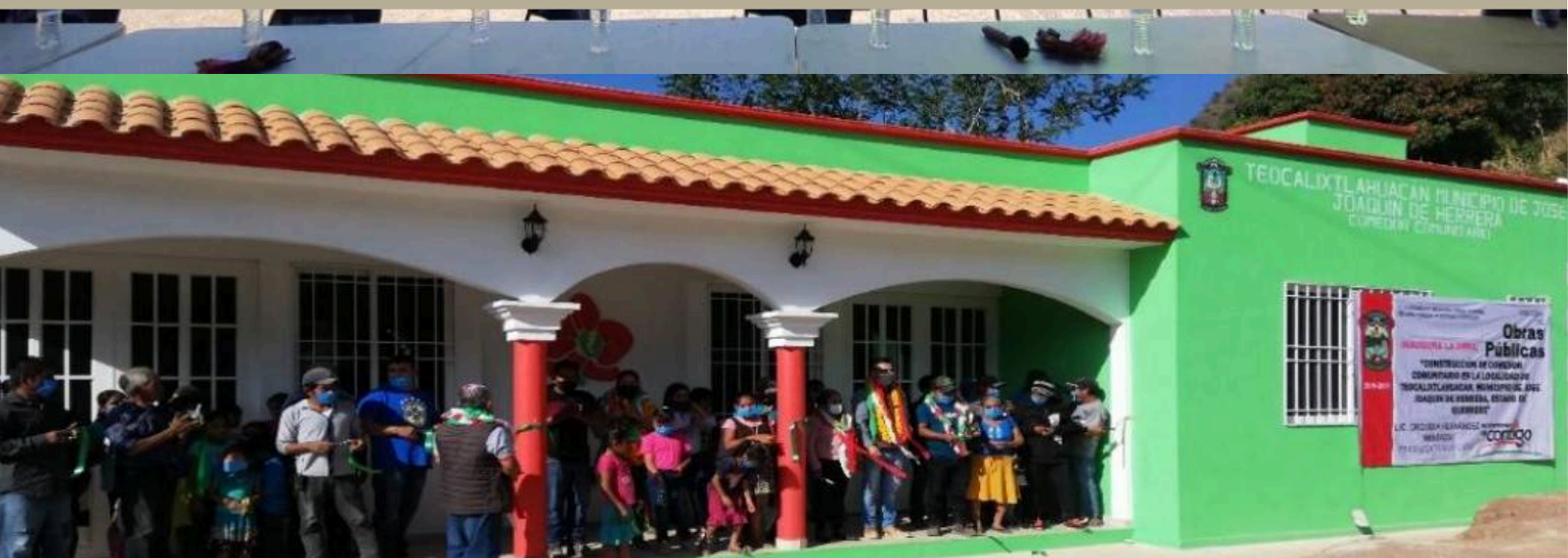
Construcción de comedores comunitarios, localidad Teocalixtlahuacán.
