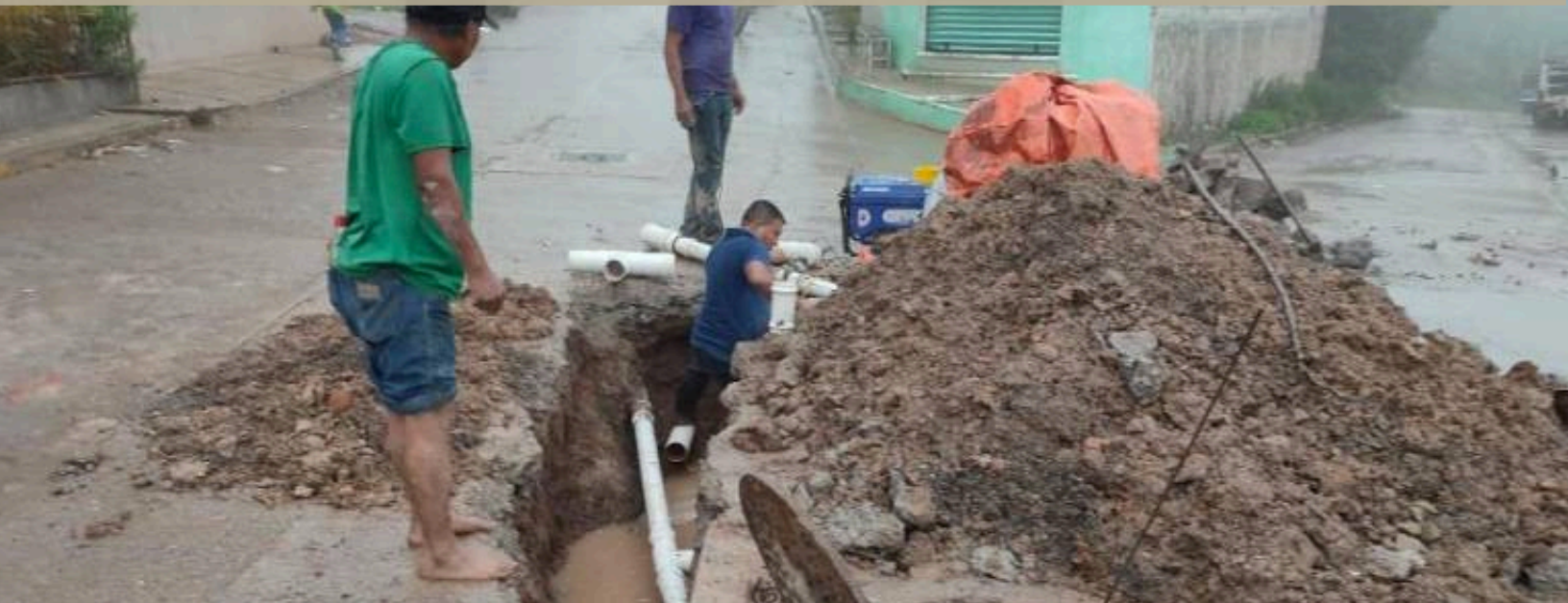
Desazolve de drenaje sanitario colonia piedra colorada.
