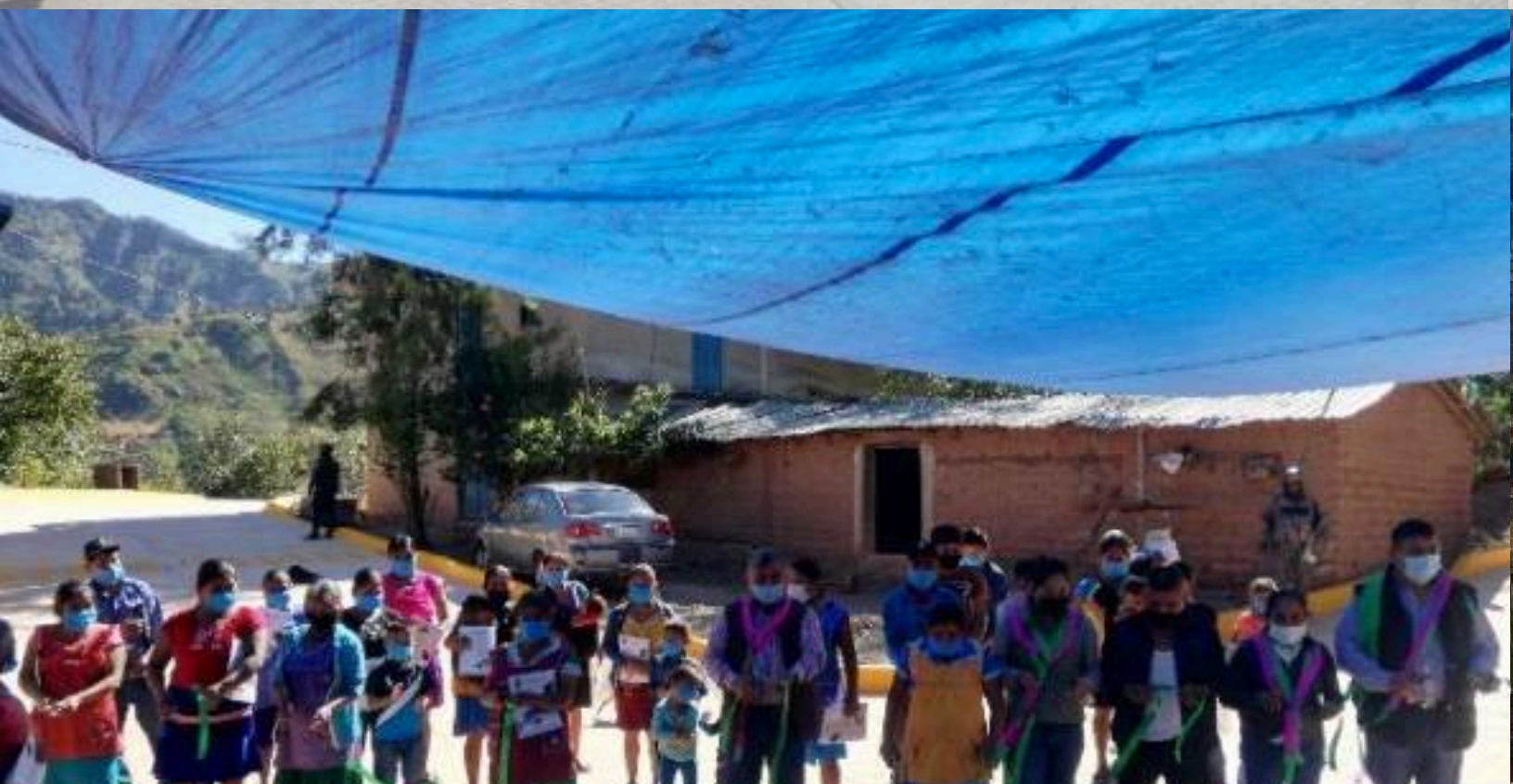
Construcción de pavimentación con concreto hidráulico en la calle principal, localida Barzamo.
