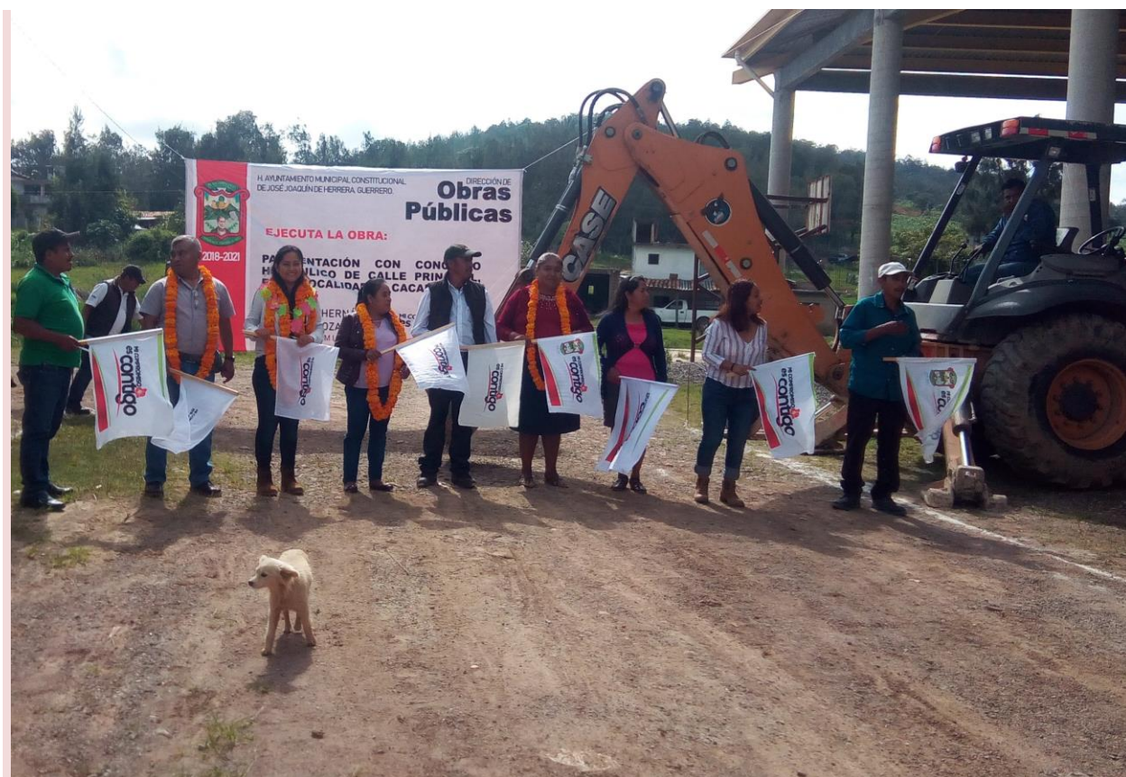
Se arrancaron los trabajos de pavimentación de calles principales en comunidades.
