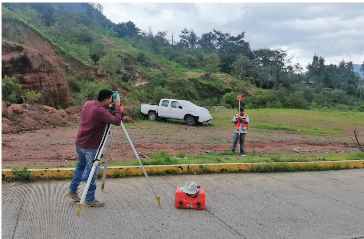
Trabajos de levantamiento topográfico para la construcción del Centro de Salud de Servicios Ampliados.
