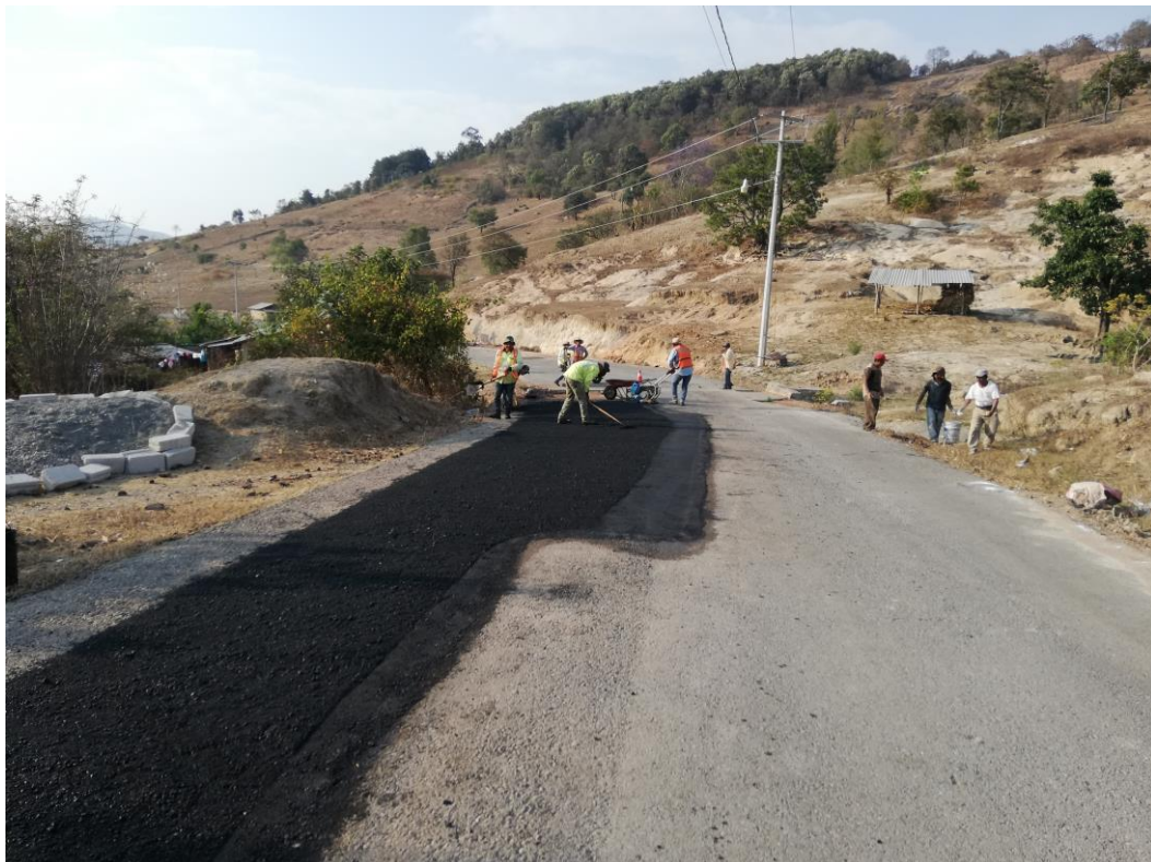
Rehabilitación del cruceo tramo Tlachimaltepec-Temixco
